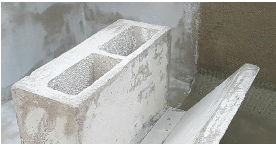
Figura 3 – Fôrma para moldagem
