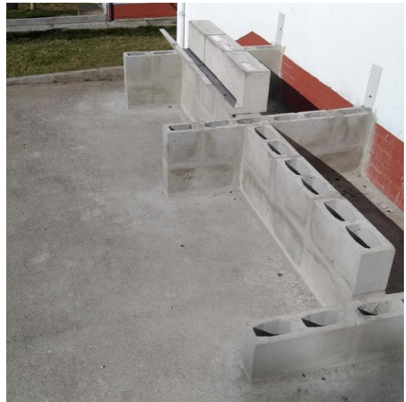
Figura 4 – Início da construção
