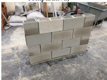
Figura 4 – Alvenaria com o método de blocos de encaixe
