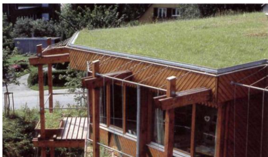
Figura 1 – Telhado verde em edificação [1]
