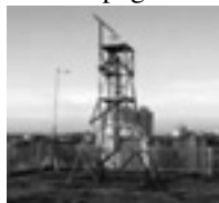
(a) Câmeras panorâmicas comuns instaladas na torre
