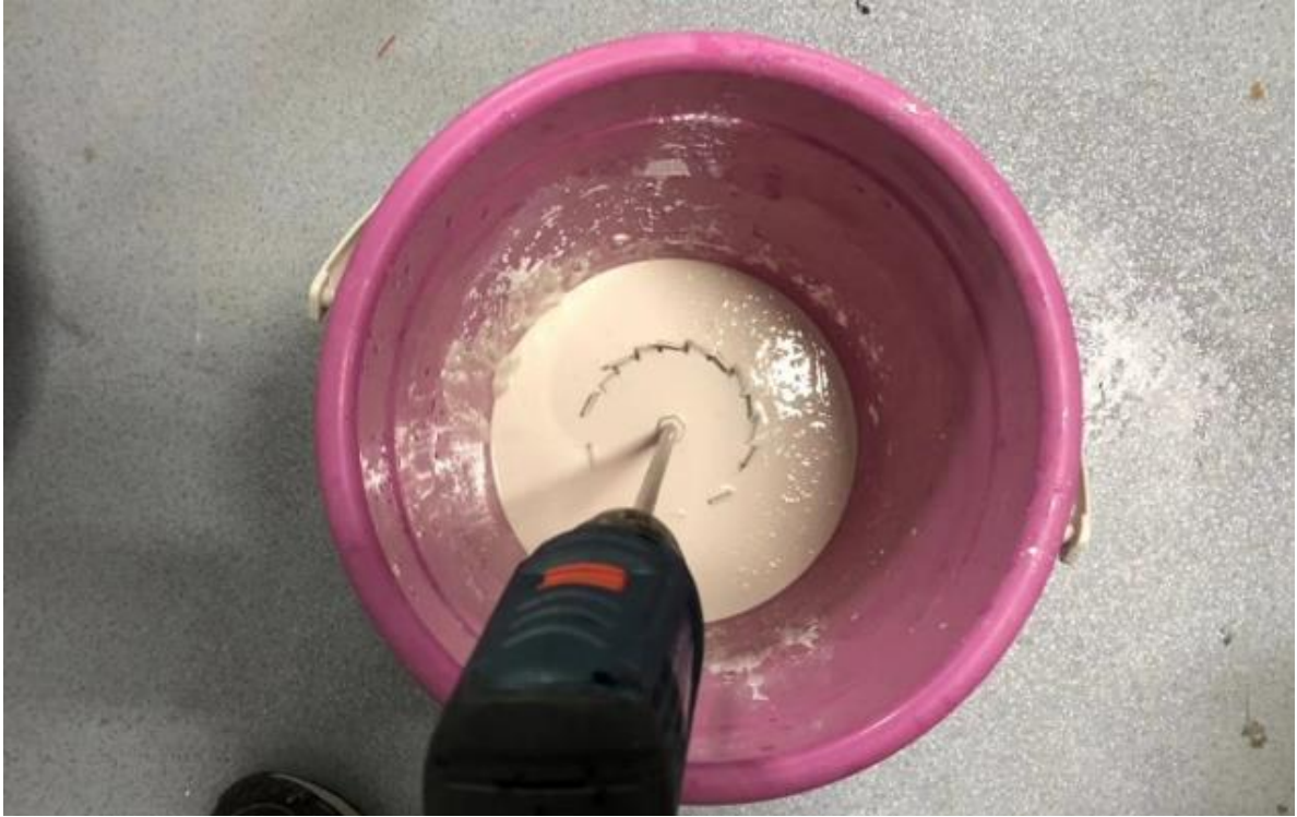
Figura 4 - Agitação da mistura de água e pó de gesso.
